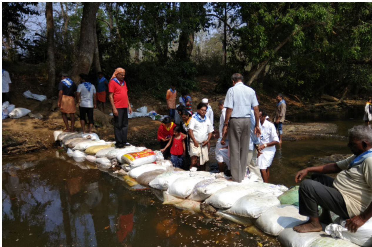
Limpieza de Lechos de Ríos
